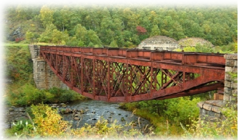
Шабартуйский комплекс – железный мост и железобетонный двухпролетный виадук
