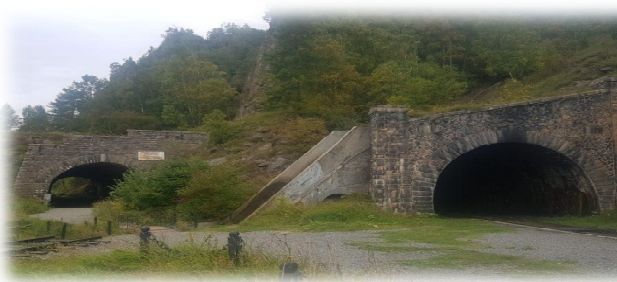
Киркирей. Здесь пробиты два параллельных тоннеля
