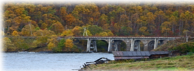
Станция Старая Ангасолка. Здесь расположен уникальный каменный арочный виадук Ангасольский
